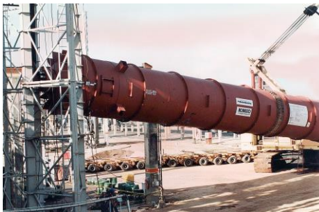
Figura 4 – Equipamento sob as Torres de Içamento.
