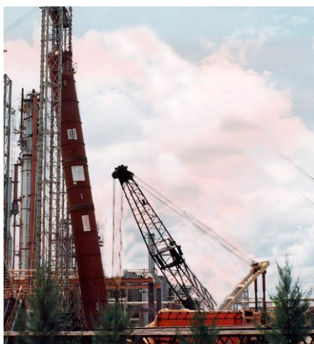
Figura 6 – Equipamento na fase final de verticalização.
